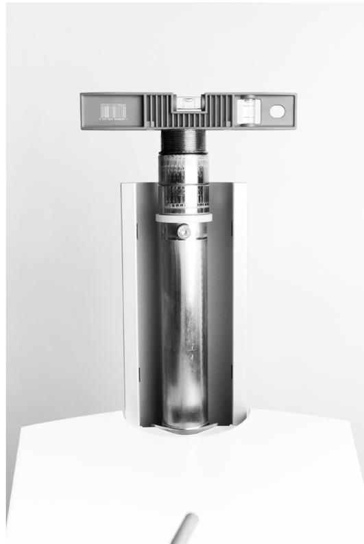
Figure 21 – Réglage de la borne suivant l'axe transversal (B)
