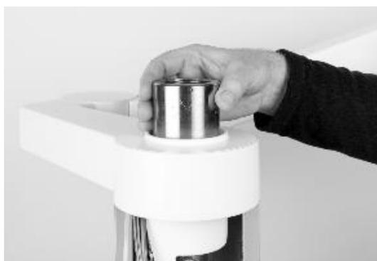
Figure 36 – Engager l'écrou sur la colonne de la borne
