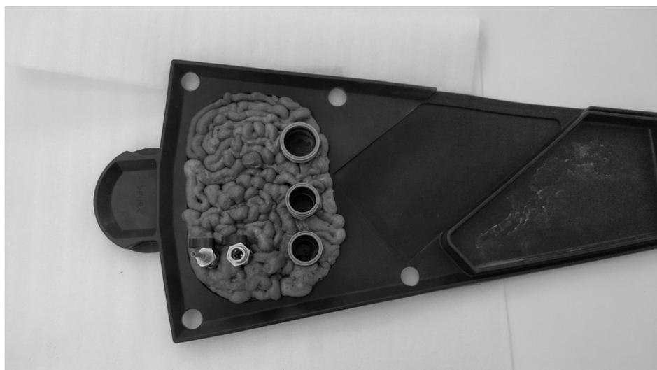
**Figure 13 – Calfeutrement du pourtour de la plaque de protection-incendie avec la mousse ignifuge**
