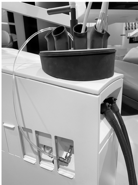
Figur 74 - Desinfektion av vattenledningen
