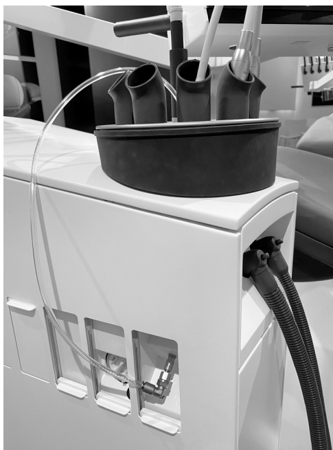
Figur 75 - Desinfektion av vattenledningen
