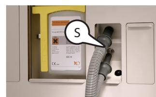
Saugschläuche auf Desinfektionsstutzen
