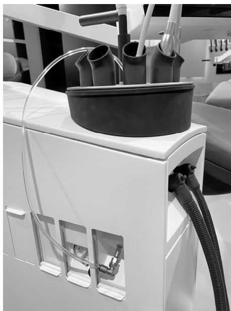
Figure 74- Désinfection des conduites d'eau
